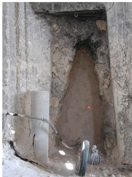
Fig. 12- Particolare, alimentazione della calcara
