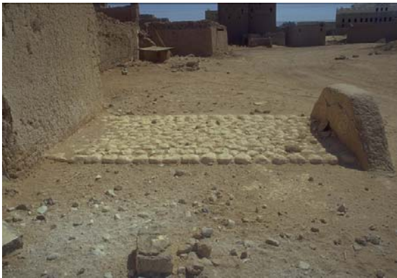
Fig.3- Piano per l'idratazione della calce
