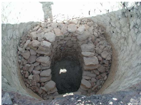
Fig. 11- La messa in opera le pietre all'interno del forno
